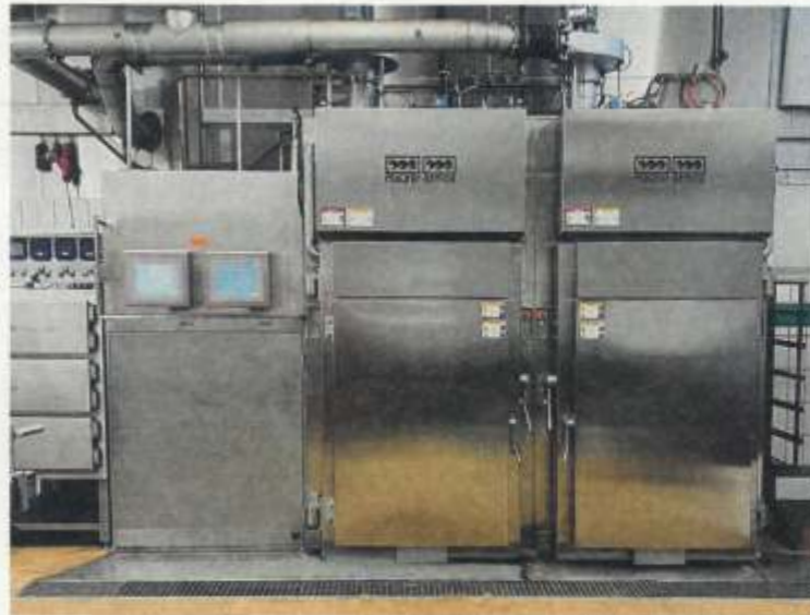
Nach mühevoller Zentimeterarbeit endlich am Platz: die neuen Rauchanlagen des Hauses Stirner-Sinn. Foto: pgö
